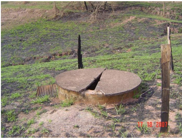
Poço do tipo cacimba perfurado em solo de alteração da Formação Corumbataí.
