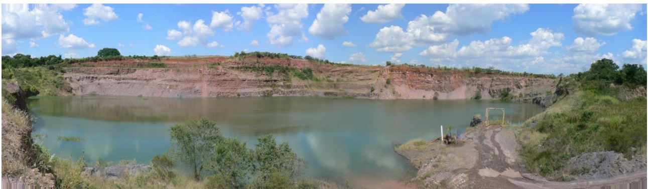
Cava de mineração na área do polo ceramista inundada por águas pluviais.
