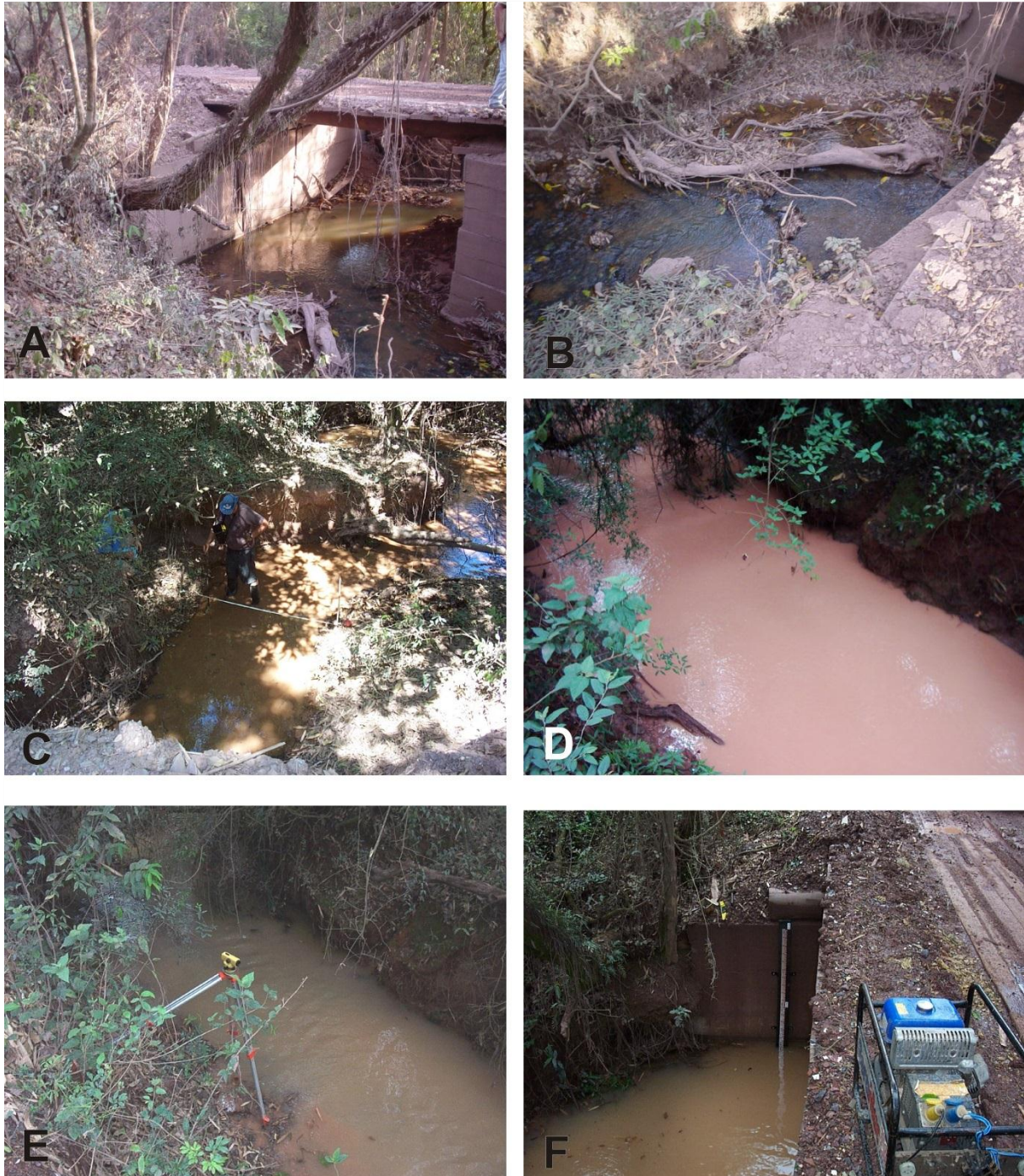
Figura 10 - Estação Ponte de Madeira: (A, B) trecho selecionado para implantação da estação; (C) medições da seção transversal do córrego; (D) aspecto do córrego após chuvas; (E) nivelamento da régua; (F) régua de medição instalada.
