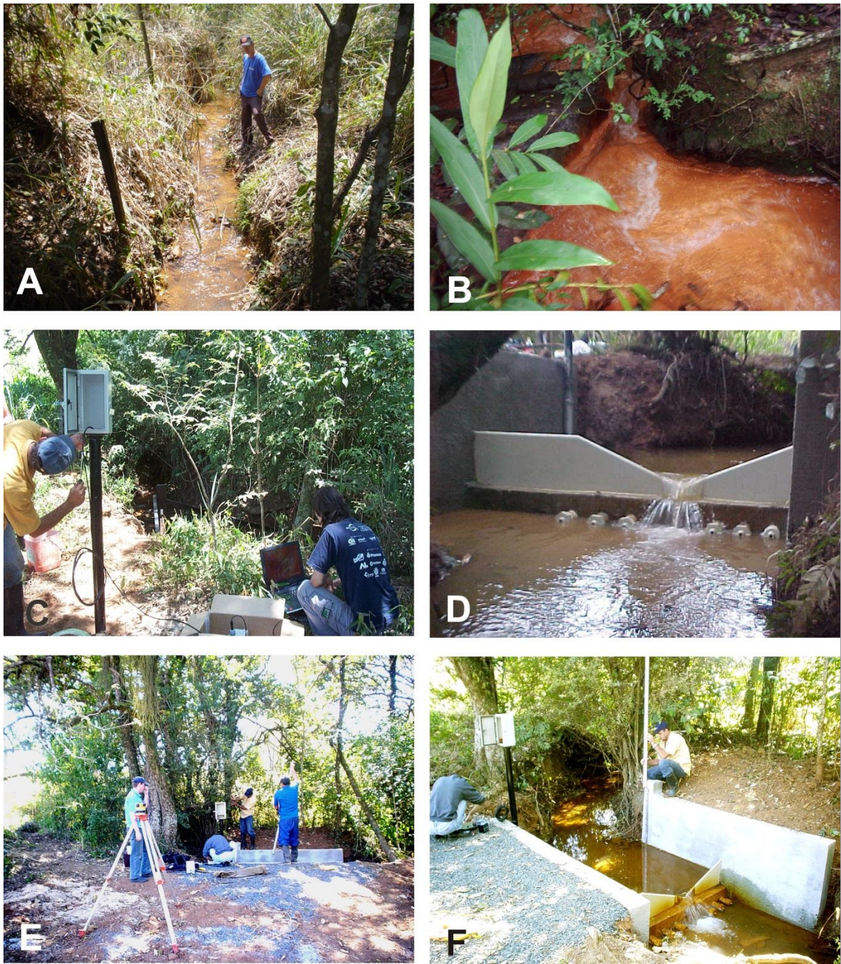
Figura 8 - Estação Diabásio: (A) vista do trecho selecionado para implantação da estação; (B) detalhe do córrego; (C) instalação do sistema de monitoramento; (D) vertedor instalado; (E) nivelamento do vertedor; (F) calibração da régua com transdutor.
