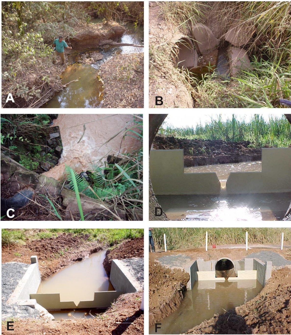
Figura 9 - Estação Tubulão: (A) vista do córrego à jusante do tubulão; (B) vista do tubulão de passagem sob a estrada; (C) córrego à jusante do tubulão após chuvas; (D, F) implantação do vertedor.
