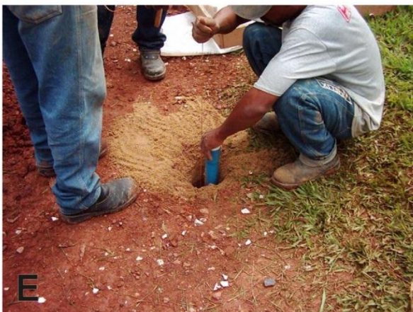
Figura 6 – Instalação dos poços de monitoramento. Perfuração a trado (A, B); colocação do revestimento (C, D); colocação do pré-filtro (E); cimentação da laje de proteção e colocação da tampa com cadeado (F).
